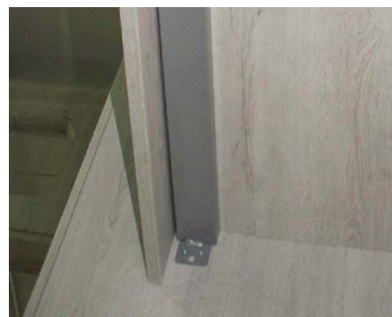
DETALLE: Refuerzo metálico interior puente
